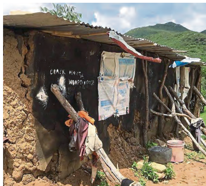
Ein paar Holzbalken stützen die Lehmwände der Familienhütte provisorisch von außen.
